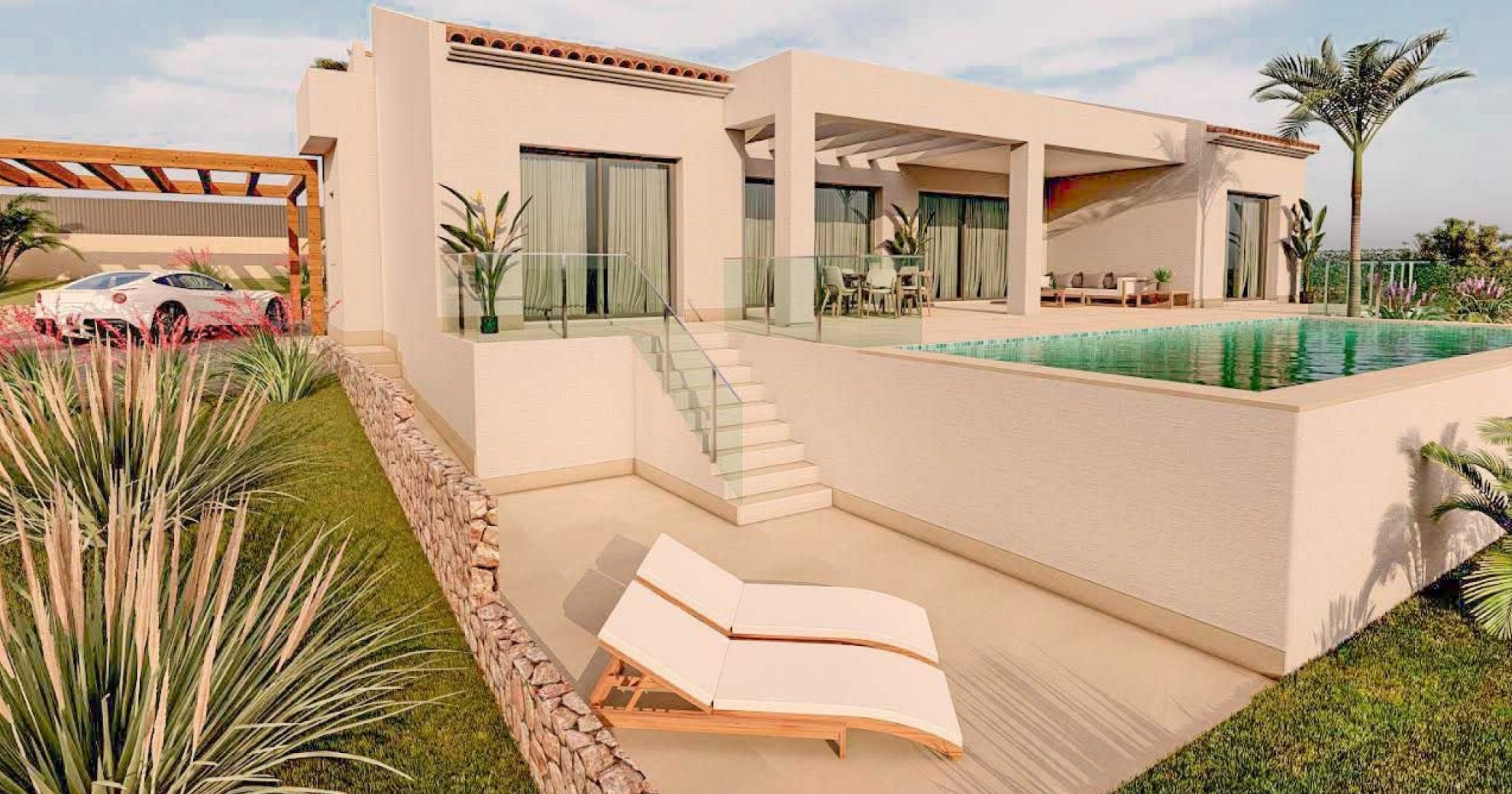
Villa im Bau in Las Laderas , Jávea
