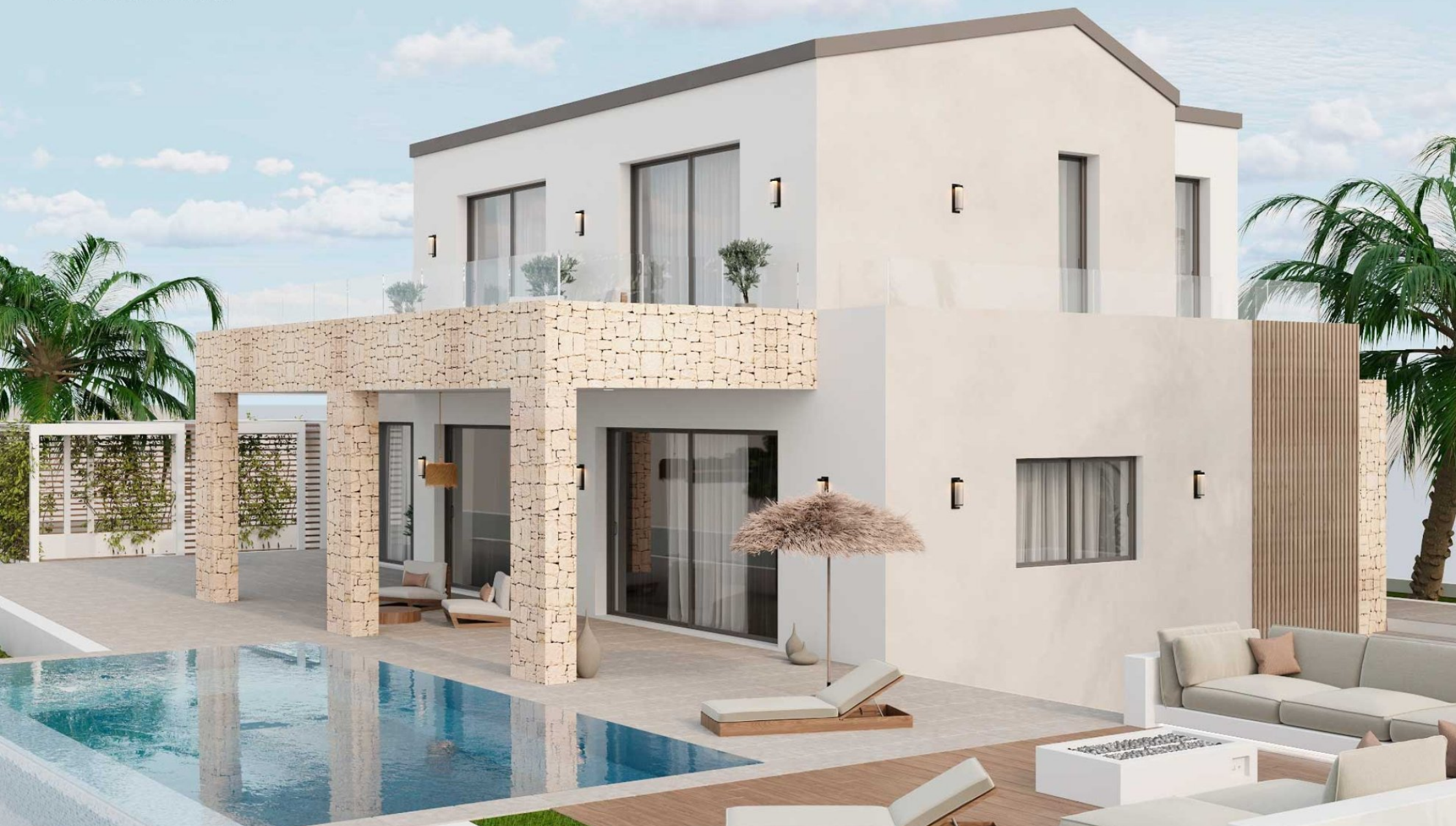
Villa in aanbouw in Jávea
